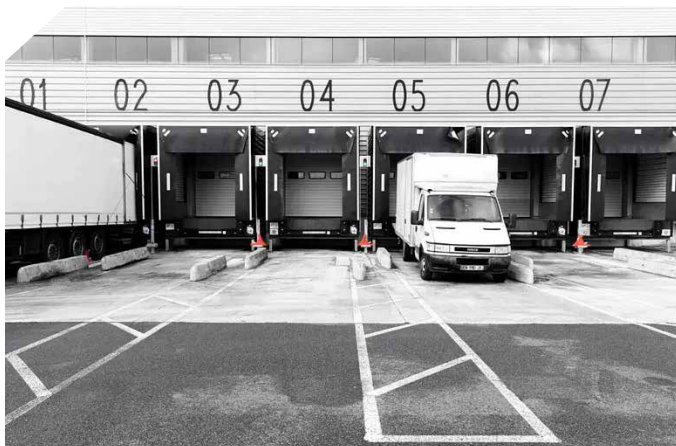
25 quais du site ID Logistics à Châtres sont équipés du système portable POWERCHOCK 3.
