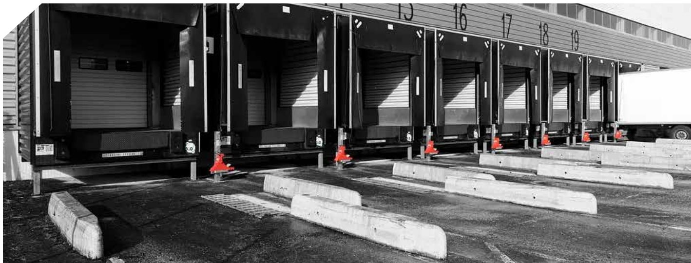
ID Logistics Châtres sécurise ses quais avec le système de retenue POWERCHOCK 3.
